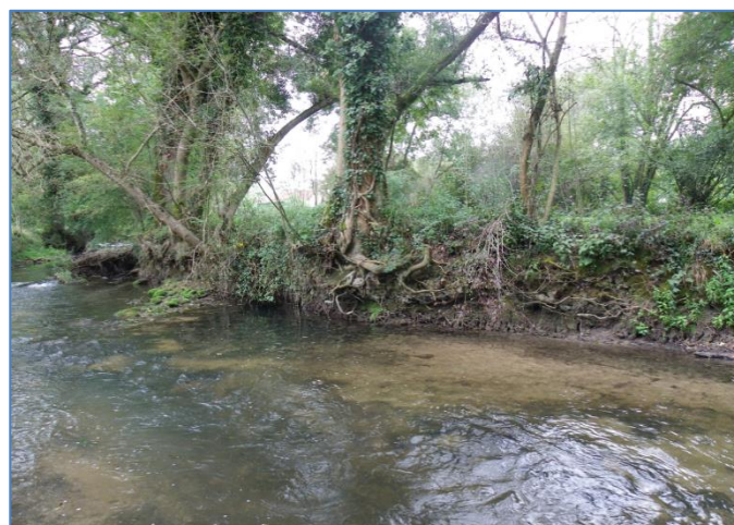
Figure 75 – Secteur d'incision du lit de la Lizonne engendrant une déstabilisation de la berge
